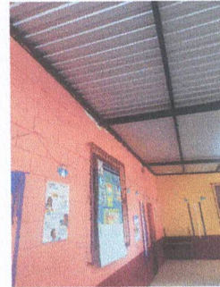
Foto 4: 5.1 INSTALACION DE CIELO FALSO
