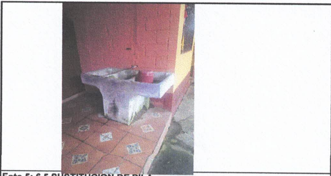
Foto 5: 6.5 SUSTITUCION DE PILA
