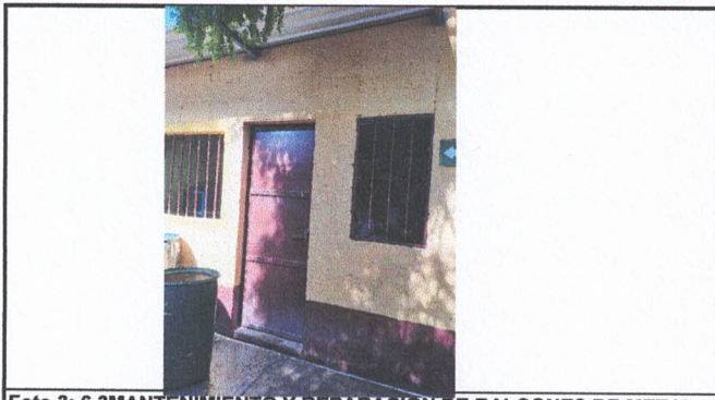
Foto 3: 6.3 MANTENIMIENTO Y REPARACION DE BALCONES DE METAL
