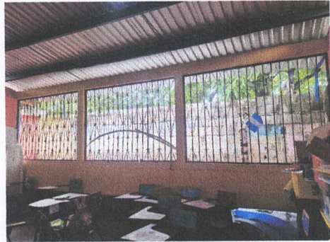
Foto 2: 4.1 INSTALACION DE CIELO FALSO
