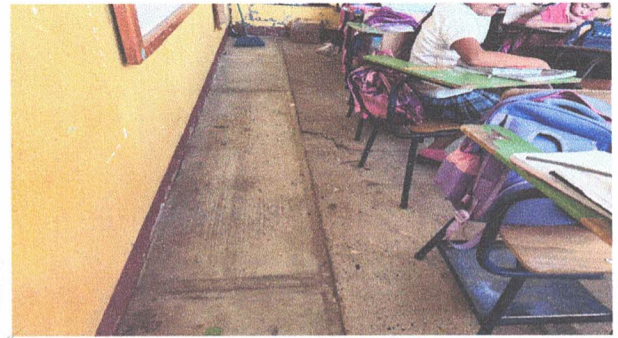
Sustitución de piso de concreto por ceramico
