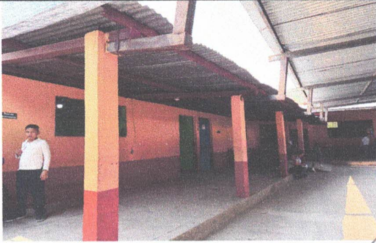
Sustitución canal pluvial
