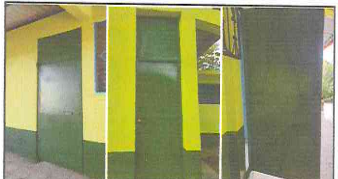
MANTENIMIENTO A 7 PUERTAS DE METAL DEL MISMO ESTILO Y MEDIDAS EN AULAS
