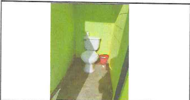
SUMINISTRO E INSTALACION DE 3 SANITARIOS EN AREA DE BAÑOS
