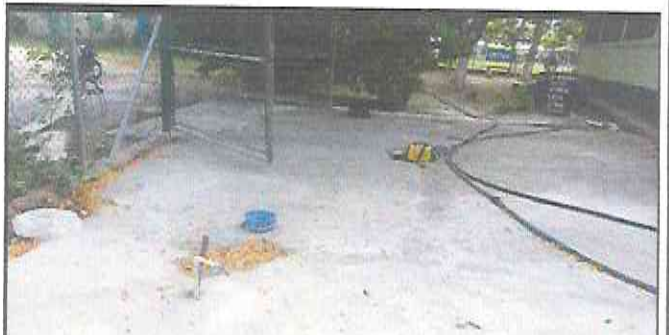
SUMINISTRO E INSTALACION DE 49 M2 PISO DE TORTA DE CEMENTO EN AREA DE ENTRADA DEL ESTABLECIMIENTO
