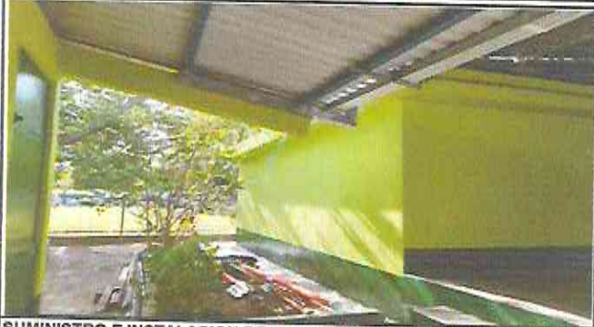
SUMINISTRO E INSTALACION DE CANAL DE 3 ML EN AREA DE AULA DE 4 GRADO
