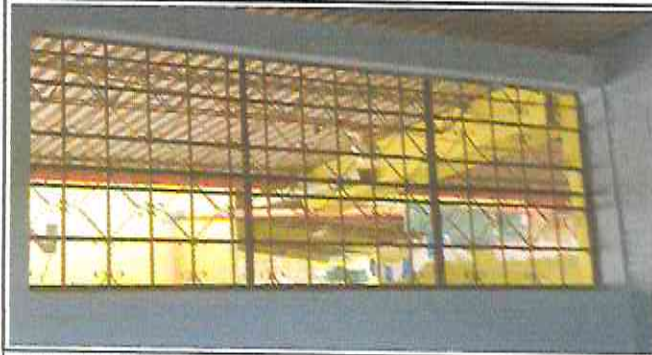
INSTALACION DE 55 M 2 DE MOSQUITEROS EN AULAS DE PRIMERO, SEGUNDO Y TERCER GRADO
