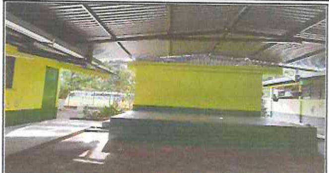
SUMINISTRO E INSTALACION DE 72 M2 DE ESTRUCTURA DE METAL Y 72 M2 DE LAMINA TROQUELADA ALUZINC CALIBRE 26 EN AREA DE ESCENARIO.
