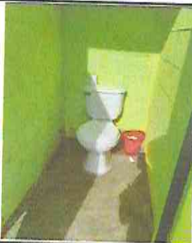
SUMINISTRO E INSTALACION DE 3 SANITARIOS EN AREA DE BAÑOS
