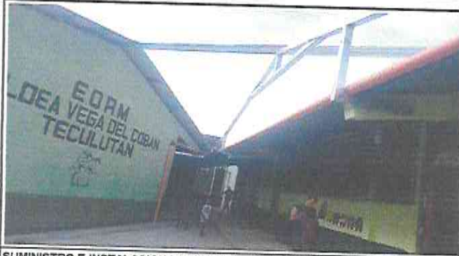
SUMINISTRO E INSTALACION DE 70 M 2 DE ESTRUCTURA DE METAL Y 70 M 2 DE LAMINA TROQUELADA ALUZINC CALIBRE 26 EN AREA EXTERIOR DE AULA DE CUARTO "A".
