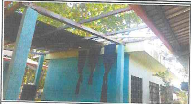
SUMINISTRO E INSTALACION DE 72 M 2 DE ESTRUCTURA DE METAL Y 72 M 2 DE LAMINA TROQUELADA ALUZINC CALIBRE 26 EN AREA DE ESCENARIO.
