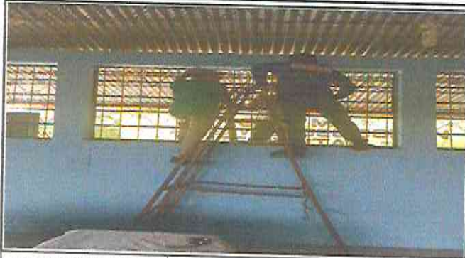
INSTALACION DE 55 M 2 DE MOSQUITEROS EN AULAS DE PRIMERO, SEGUNDO Y TERCER GRADO
