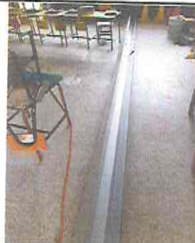
SUMINISTRO E INSTALACION DE CANAL DE 13 ML EN AREA DE AULA DE AULA DE TELESECUNDARIA ANEXA AL ESTABLECIMIENTO
