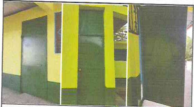
MANTENIMIENTO A 7 PUERTAS DE METAL DEL MISMO ESTILO Y MEDIDAS EN AULAS
