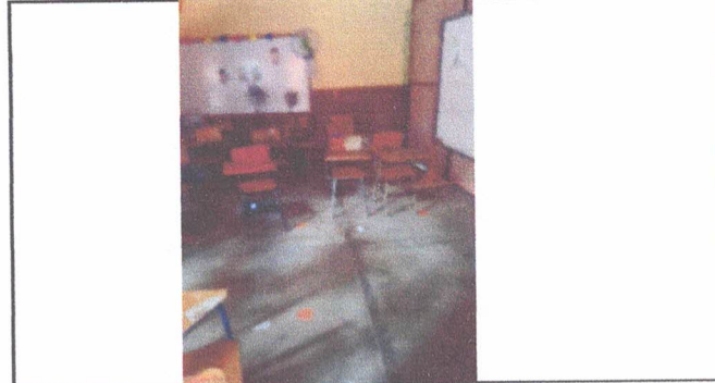
Foto 4: 5.1 SUSTITUCION PISO DE GRANITO
