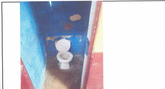
Foto 3: 2.1 SUSTITUCION DE PISO DE CONCRETO POR PISO CERAMICO 2.2 SUMINISTRO E INSTALACION DE CERAMICO EN PAREDES 2.3 SUSTITUCION DE INODOROS
