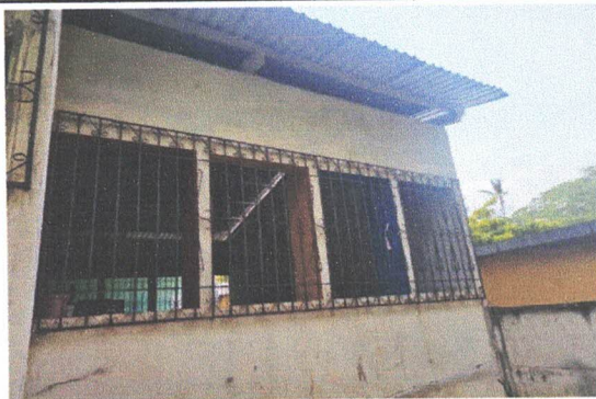
Foto 5: PINTURA EN MUROS EXTERIORES E INTERIORES
