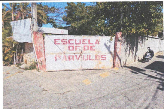
Foto 6: REPARACION DE PORTON METALICO
