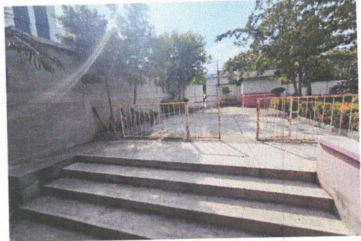
Foto 2: SUSTITUCION DE BARANDAS
