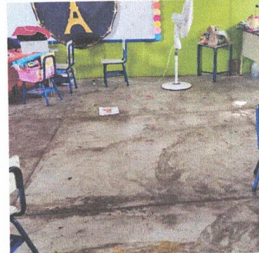
Foto 4: SUSTITUCION DE PISO DE CONCRETO
