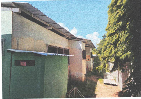
Foto 7: AMPLIACION DE TECHO CON LAMINA TROQUELADA ALUZINC CALIBRE 26
