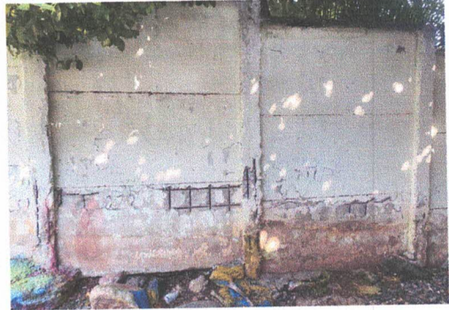
Foto 8: SUSTITUCION DE TAPIAL PREFABRICADO A BLOCK
