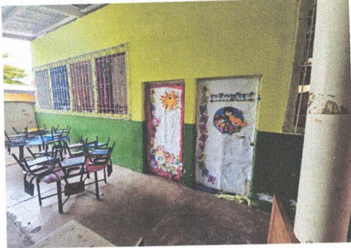
Foto 1: REPARACION DE PUERTAS DE METAL
