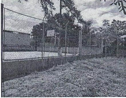
Foto 1: muros perimetral que es dañado constantemente por las actividades deportivas de la cancha, se propone cambio de malla por block.
