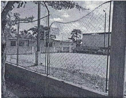
Foto 3: malla existente con daños en toda su extensión, necesita reparación.
