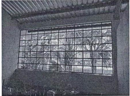
Foto 6: ventanería dañada, se propone la instalación de ventanería PVC.
