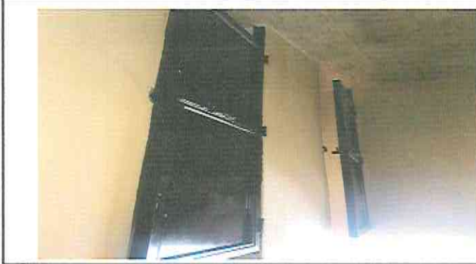
Sustitución de puertas de baños ya instaladas.
