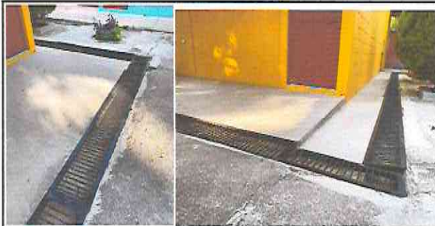
Foto 11: Reparación de cuneta de concreto
