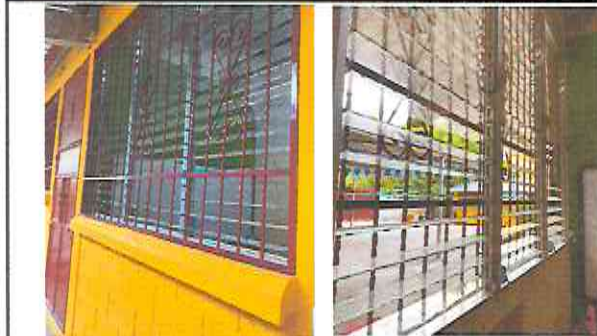
Foto 7: sustitución de ventana en mal estado por balcón y ventana de paletas
