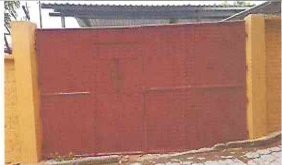
Foto 10: Mantenimiento a Portón
