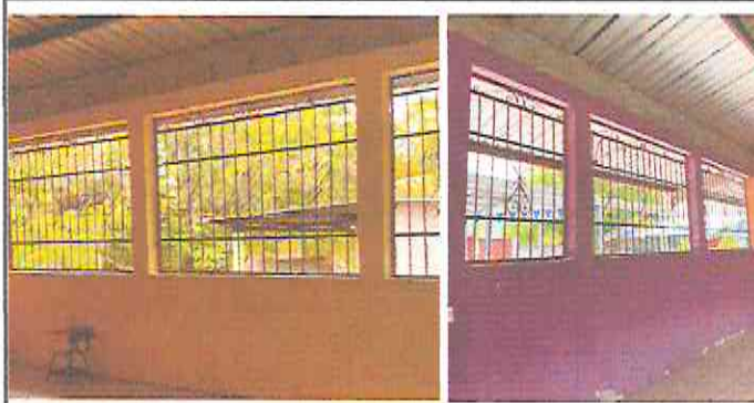
Foto 4: Cerramiento de mojinete + mano de obra
