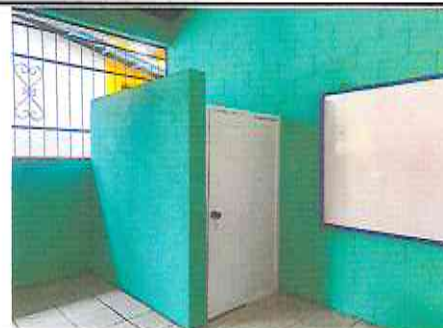
Foto 12: Sustitución de puerta en servicio sanitario
