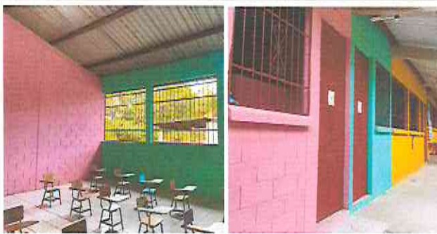
Foto 9: pintura en paredes dañadas
