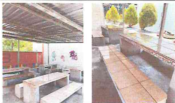
Foto 6: Sustitución de azulejo en mesas y bancas
