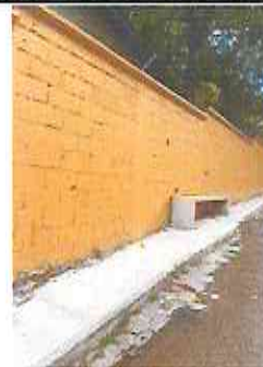
Foto 8: Reparación de banqueta de concreto y banca
