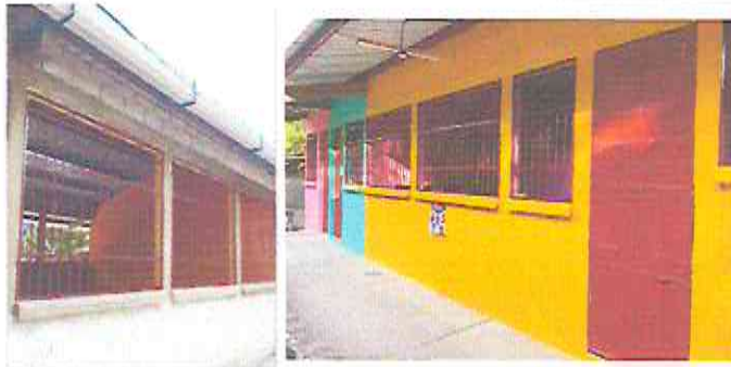
Foto 1: sustitución de ventanas en mal estado por balcón
