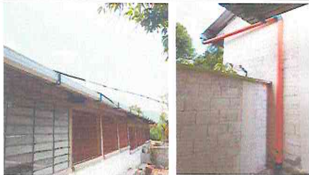
Foto 3: Sustitución de canal de metal + bajada pluvial
