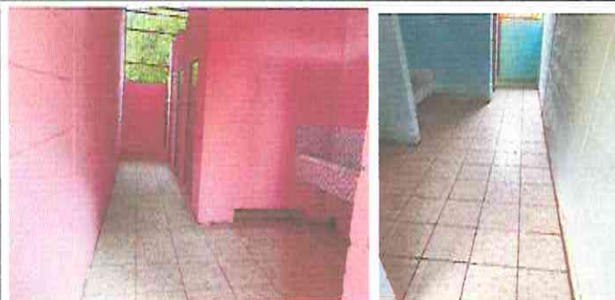
Foto 2: Sustitución de piso por piso antideslizante en baños
