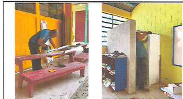
Foto 12: Sustitución de puerta en servicio sanitario
