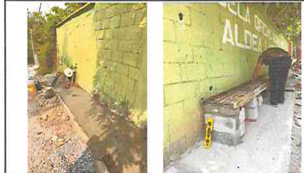
Foto 8: Reparación de banqueta de concreto y banca
