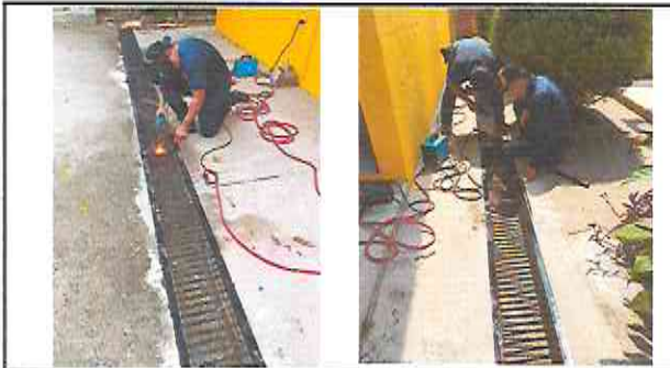
Foto 11: Reparación de cuneta de concreto
