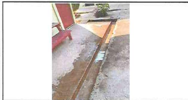
Foto 11: Reparación de cuneta de concreto
