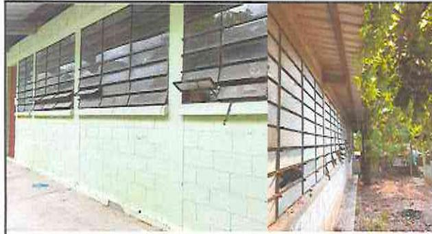
Foto 1: sustitución de ventanas en mal estado por balcón
