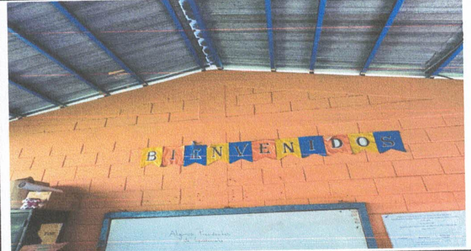
Sustitución de Techo de cielo falso
