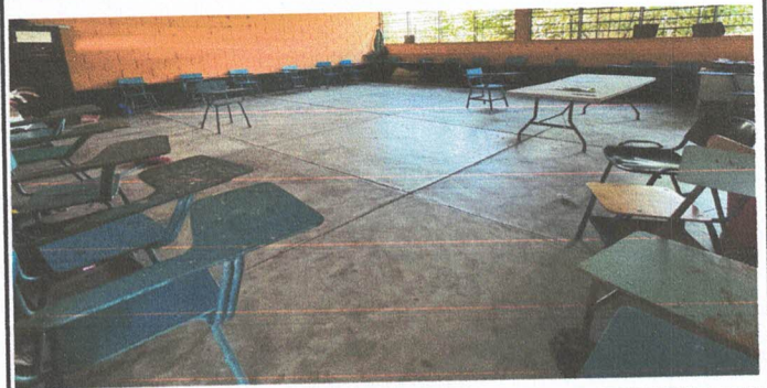
Sustitución de piso de concreto por ceramico
