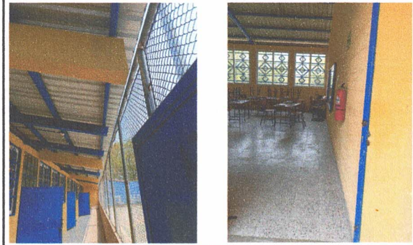
PINTUARA EN INTERIORES Y EXTERIORES EN TODO EL ESTABLECIMIENTO EDUCATIVO
