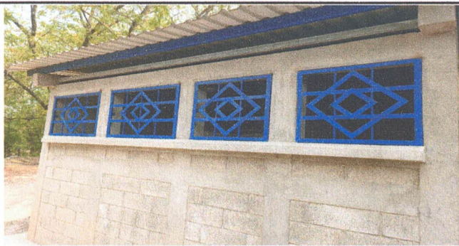
INSTALACION DE 4 MOSQUITEROS SOBRE BALCONES LADO EXTERIOR DE AREA DE BAÑOS, ESTO PORQUE PERSONAS INESCRUPULOSAS TIRARON BOMBAS PARA ADENTRO DEL AULA Y ROMPIERON UN LAVAMANOS QUE TAMBIEN SE SUSTIUIRA
