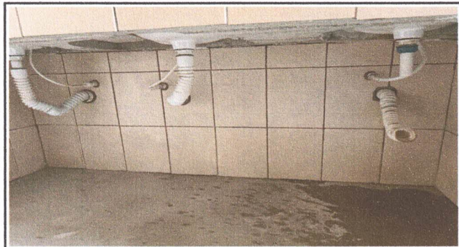
SUSTITUCION DE ACCESORIOS DE LAVAMANOS, LLAVE, SIFON Y TUBO DE ABASTO
