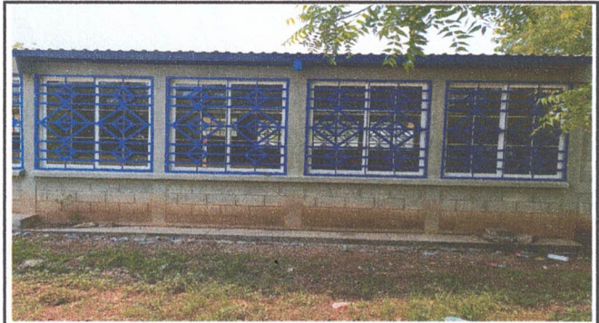
INSTALACION DE 14 MOSQUITEROS SOBRE BALCONES LADO EXTERIOR DE LAS AULAS, ESTO PARA EVITAR QUE PERSONAS INESCRUPULOSAS SIGAN ROMPIENDO LOS VIDRIOS DE LAS VENTANAS.
