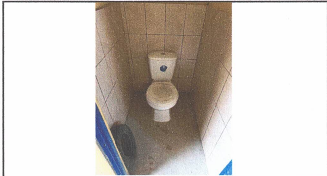
CAMBIO DE TUBERIA PVC DE AGUAS NEGRAS EN SANITARIO TAPADO
