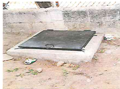
Foto 6: TAPADERA DE CAJA DE AGUA
