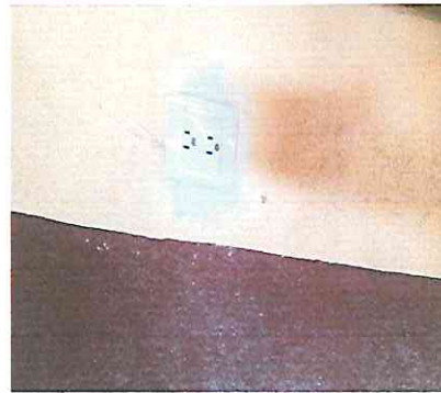
Foto 2: INSTACION DE TOMACORRIENTE
