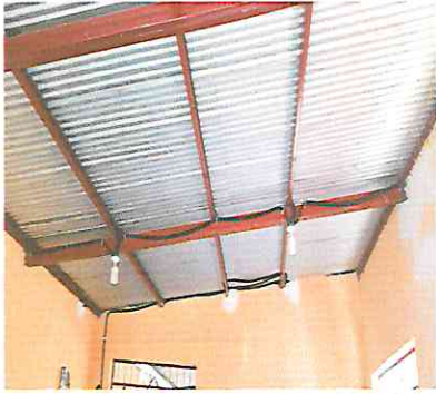
Foto1: ILUMINACION DE AULA TERMINADA
