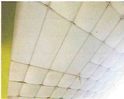
Foto 3: SE INSTALO EL CIELO FALSO QUE FALTABA DEBIDO A LAS GOTERAS DE AGUA
