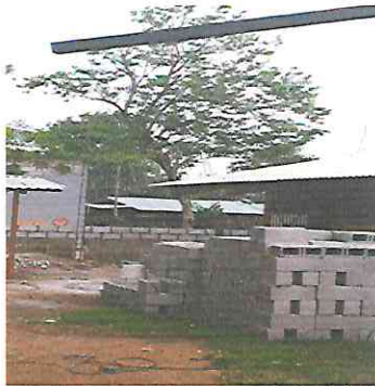
Foto 5: TRABAJANDO MURO PERIMETRAL
