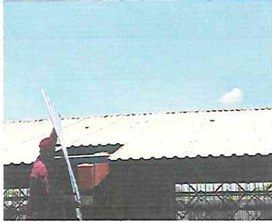
Foto1: TRABAJANDO ILUMINACIÓN EN AULA
