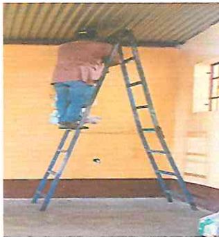
Foto 3: TRABAJANDO GOTERAS DE CUBIERTA
