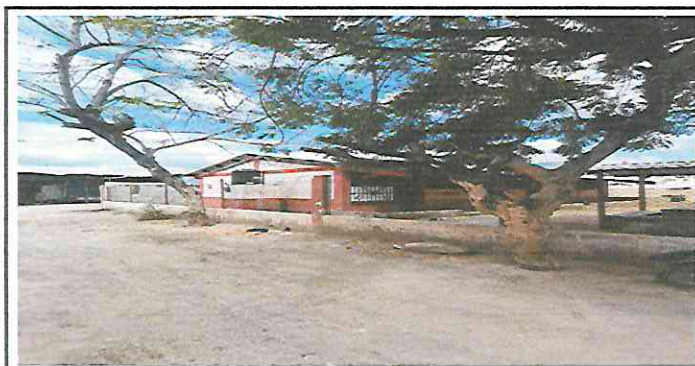
Muro de Circulación a Cambiar malla por block
