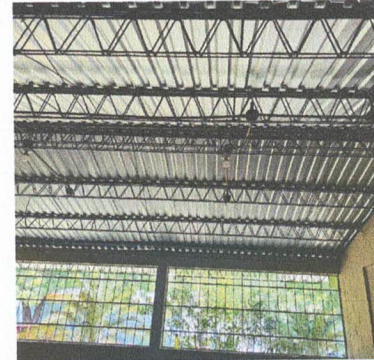
Foto 4: Reparación de Cableado eléctrico .
