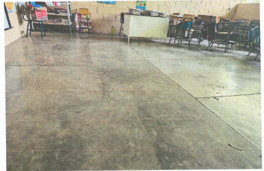
Foto 8: Sustitución de piso a piso con Ceramico en Aula 2.
