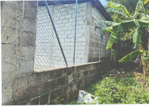
Foto 1: Sustrucción de Tapial de Malla a Block + mano de Obra.
