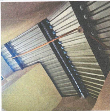
Foto 5: Reparación de Cableado eléctrico .
