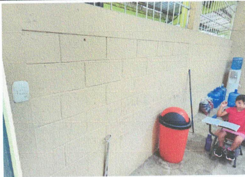
Foto 3: Pintado en Muros interiores
