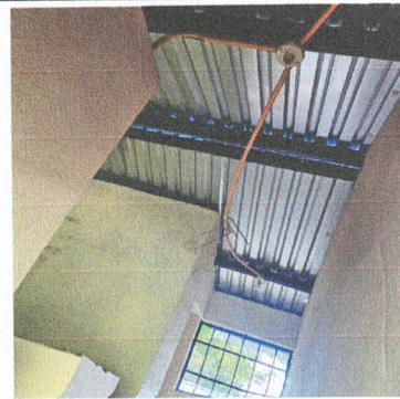
Foto 6: Reparación de Cableado eléctrico .
