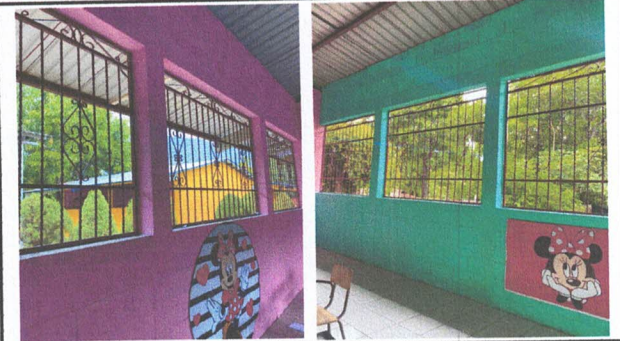
Foto 2: MODULO 5 AULA II, FABRICACIÓN E INSTALACIÓN DE VENTANAS PVC CORREDIZA
