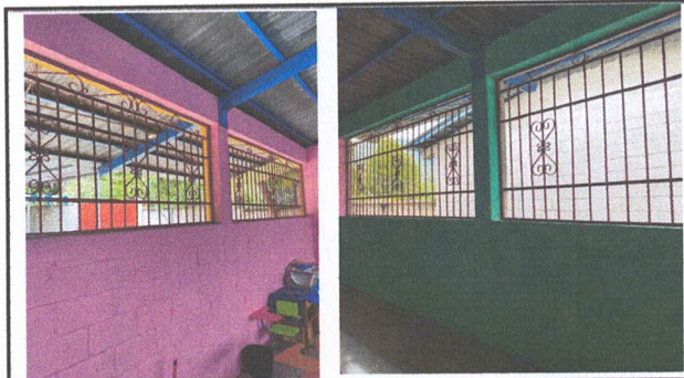
Foto 3: MODULO 6 AULA III, FABRICACIÓN E INSTALACIÓN DE VENTANA PVC CORREDIZA
