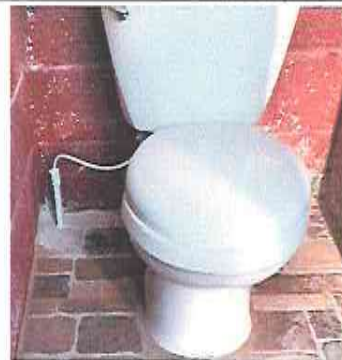
Foto 8: Suministro e Instalación de sanitario en area de baños
