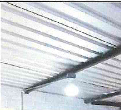
Foto 11: Instalación de Iluminación en escenario
