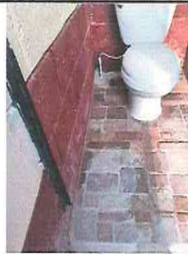
Foto 8: Suministro e instalación de sanitario en area de baños
