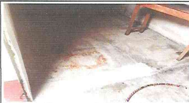
Foto 9: SUMINISTRO E INSTALACION DE PISO CERAMICO SOBRE PISO DE CONCRETO EN COCINA
