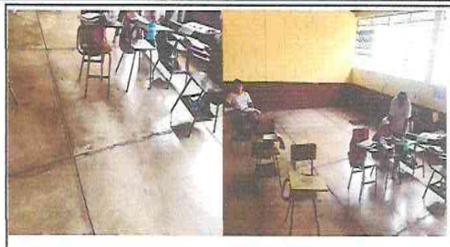
Foto 2: SUMINISTRO E INSTALACION DE PISO CERAMICO SOBRE PISO DE CONCRETO EN TODAS LAS AULAS (aula 2)
