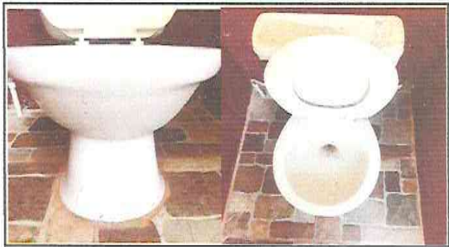
Foto 8: SUMINISTRO E INSTALACION DE SANITARIO EN AREA DE BAÑOS
