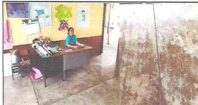
Foto 4: SUMINISTRO E INSTALACION DE PISO CERAMICO SOBRE PISO DE CONCRETO EN DIRECCION
