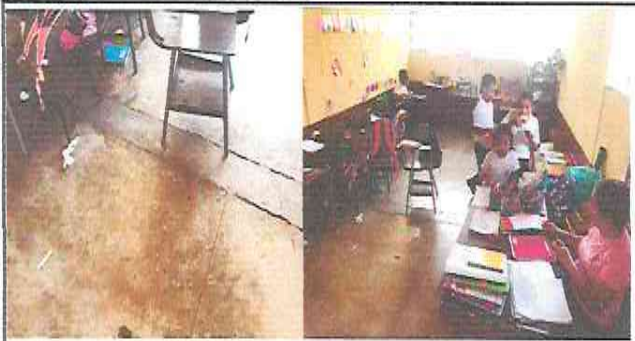
Foto 3: SUMINISTRO E INSTALACION DE PISO CERAMICO SOBRE PISO DE CONCRETO EN TODAS LAS AULAS (aula 3)
