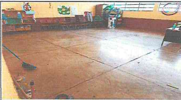
Foto 1: SUMINISTRO E INSTALACION DE PISO CERAMICO SOBRE PISO DE CONCRETO EN TODAS LAS AULAS (aula 1)
