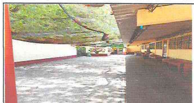
Foto 6: SUMINISTRO E INSTALACION DE ESTRUCTURA DE SOPORTE DE METAL PARA INSTALACION DE LAMINA EN AREA DE ESCENARIO Y PATIO
