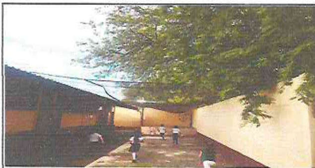
Foto 5: SUMINISTRO E INSTALACION DE LAMINA TROQUELADA ALUZING CALIBRE 26 EN AREA DE ESCENARIO Y PATIO
