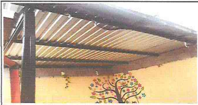
Foto 11: INSTALACION DE ILUMINACION EN ESCENARIO
