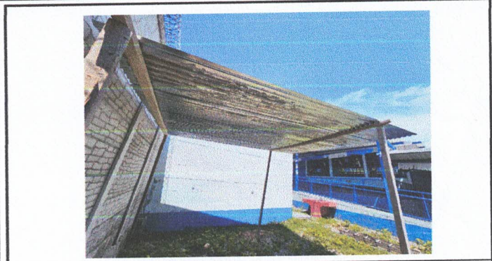
Foto1: SUSTITUCION DE LAMINA TROQUELADA ALUZINC CALIBRE 26
