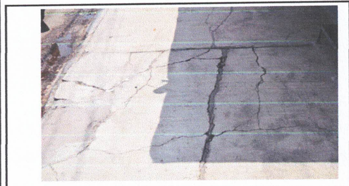
Foto 3: SUSTITUCION DE PISO DE CONCRETO
