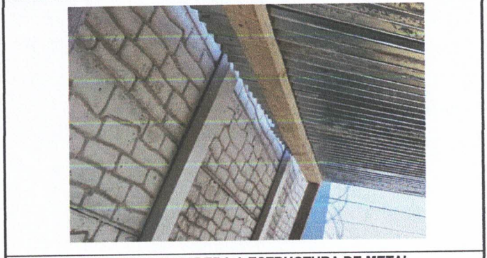
Foto 2: SUSTITUCION DEMADERA A ESTRUCTURA DE METAL
