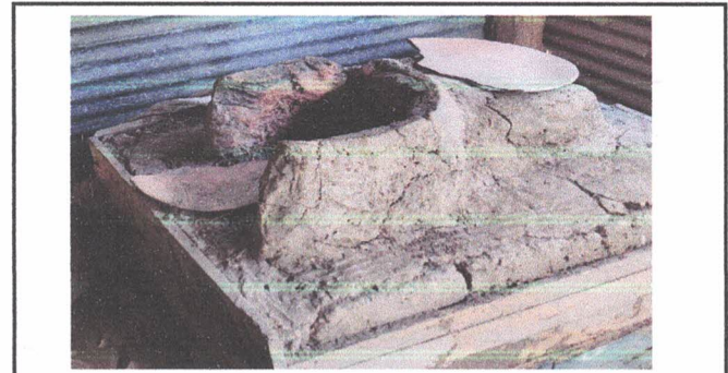
Foto 4: Sustitución de estufa rural completa (Incluye polletón, Plancha metálica y chimenea)
