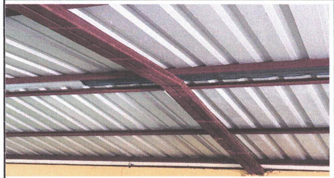
Sustitucion de soporte por metal
