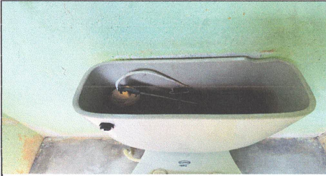
Sustitución de accesorios inodoro (contra llave, tubo de abasto y tanque)
