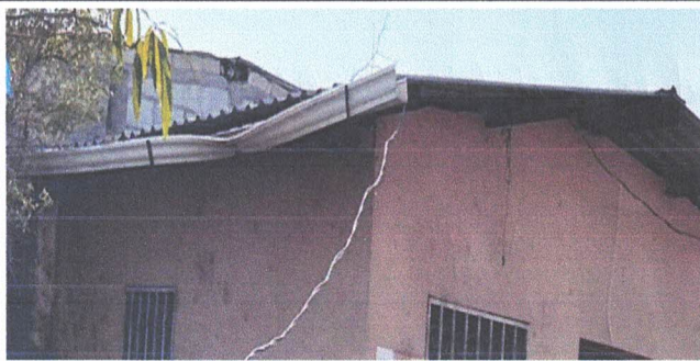
Sustitución de canal de PVC
