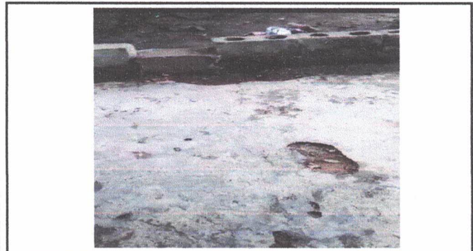
Sustitución de piso de cemento liquido
