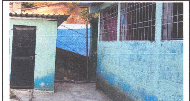
Pintura en muros interiores y exteriores en aulas y sanitarios
