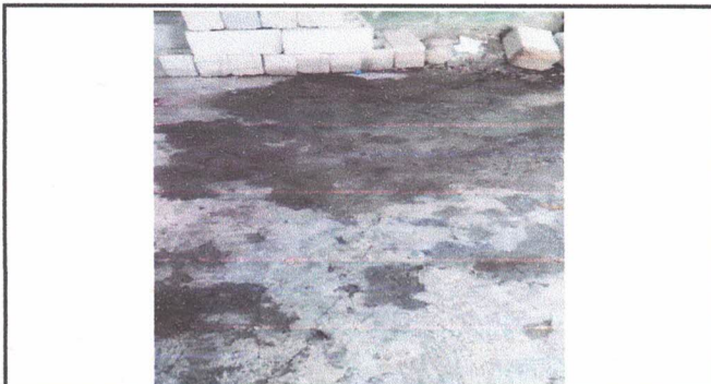
Sustitución de piso de torta de concreto
