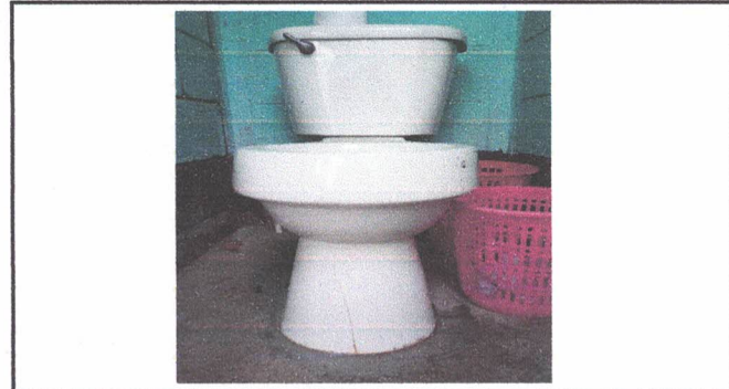
SUSTITUCIÓN DE INODORO
