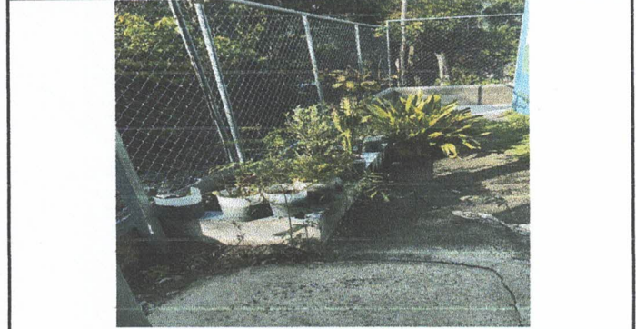
Foto 4: Reparación de arriate de block (Incluye repello, cernido y pintado) //
