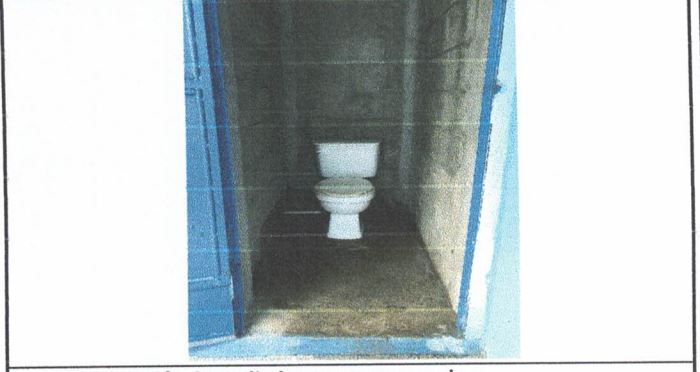
Foto 2: Sustitución de sanitario con sus accesorios ✓
