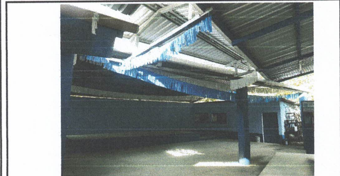
Foto 3: Sustitución de canal de bajada de agua pluvial de plástico por canal de metal de lámina troquelada calibre 26 ✓
