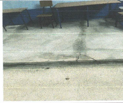
Foto 12: Sustitución de piso de torta de concreto dañada por piso cerámico
