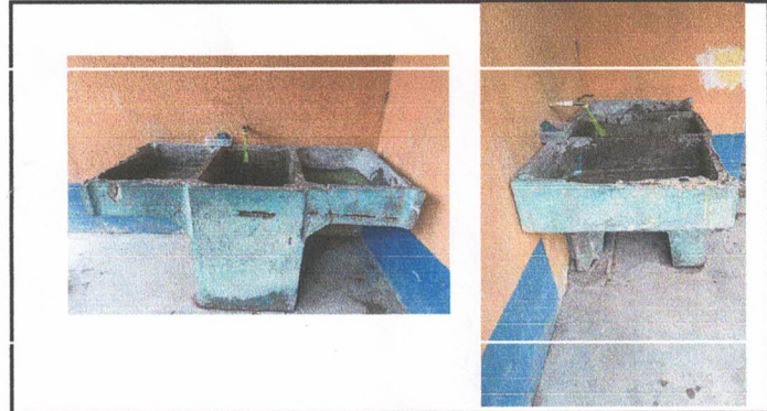
Foto 6: Sustitución de área de cocina (pila)
