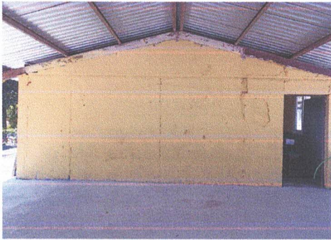
Foto 6: Reparación de paredes y cernido de paredes.
