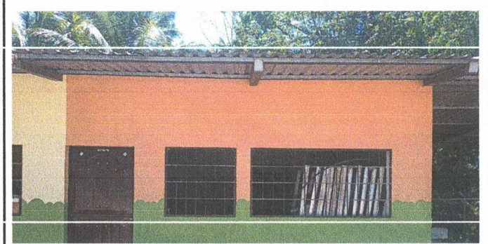
Foto 4: Instalación de ventanas corredizas con cedazo de PVC de la cocina.
