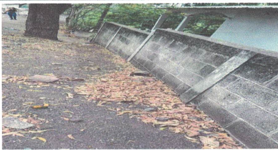
Foto 5: Reparación de muros perimetrales
