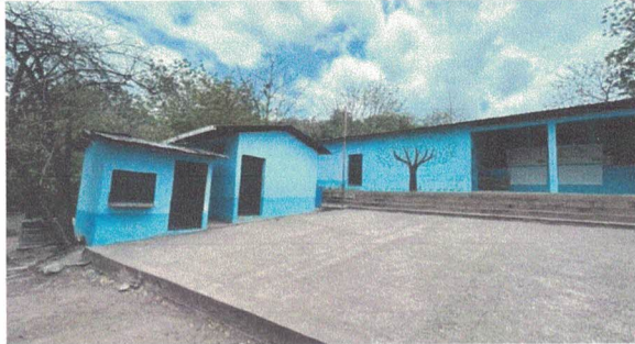
Foto 1: Sustrucción de Cubierta de lamina troquelada calibre 26
