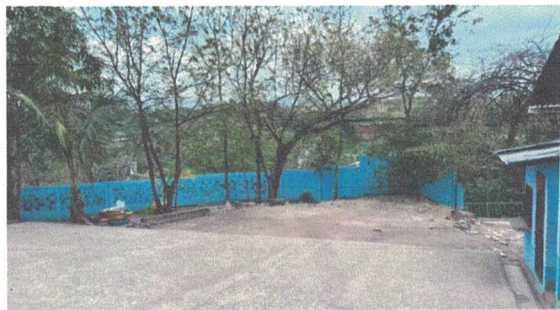
Foto 3: Aplicación de pintura a muros interiores y exteriores
