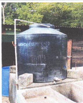
Sustitución de depósito de agua de 1100 Lt.
