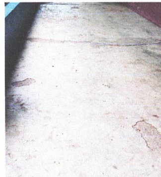
Sustitución de piso de torta de concreto
