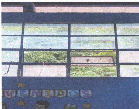
Sustitución de ventanas de vidrio y metal por ventanas corredizas de pvc
