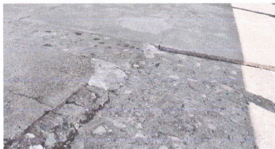
Sustitución de planchas de concreto del area del patio
