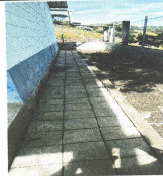
Foto 2: Reparación de banquetas de concreto
