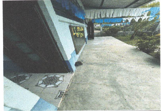
Foto 4: Sustitución de piso de torta de concreto por piso cerámico
