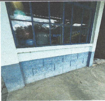
Foto 5: Sustitución de ventanas de vidrio (persianas) por ventanas de material de PVC corredizas con vidrio de 5mm de grosor de 1.80 mts de ancho por 2.50 mts de alto
