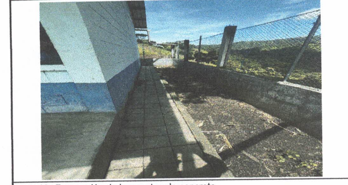
Foto 10: Reparación de banquetas de concreto
