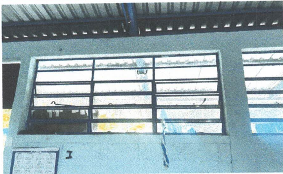
Foto 15: Sustitución de ventanas de marco metálico y vidrio por ventanas corredizas de material de PVC más vidrio de 5mm de grosor de 2.50 mts de ancho por 1.50 mts de altura
