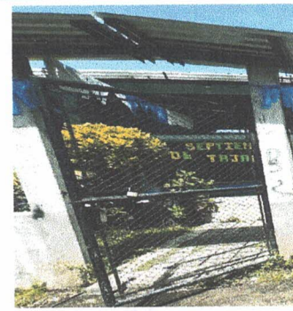
Foto 6: Mantenimiento a estructura de puerta de entrada (lijado, cambio de tubo, cepillado, sujeciones, aplicación de pintura)
