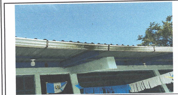
Foto 9: Sustitución de canal de pvc y sustitución de soporte
