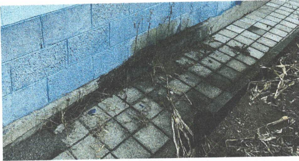
Foto 1: Reparación de banquetas de concreto
