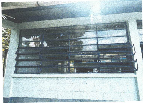
Foto 14: Sustitución de ventanas de marco metálico y vidrio por ventanas corredizas de material de PVC más vidrio de 5mm de grosor de 2.50 mts de ancho por 1.50 mts de altura
