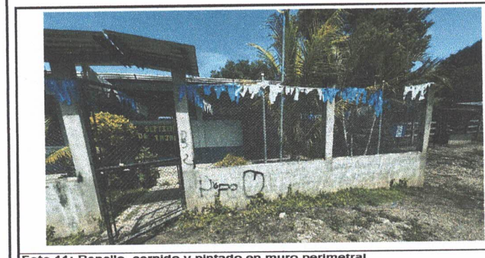
Foto 11: Repello, cernido y pintado en muro perimetral
