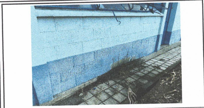
Foto 7: Pintura en muros exteriores e interiores
