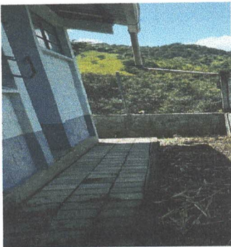
Foto 3: Reparación de banquetas de concreto
