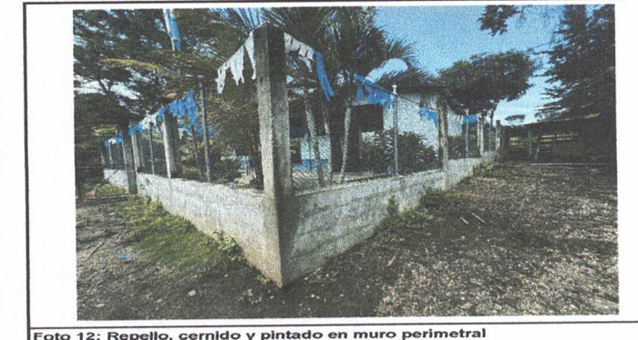
Foto 12: Repello, cernido y pintado en muro perimetral
