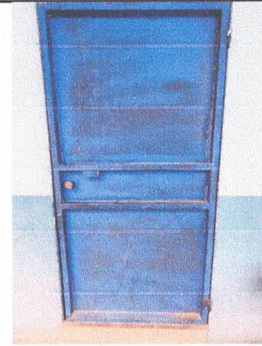
SUSTITUCIÓN DE PUERTA DE METAL ✓
