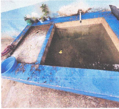
MANTENIMIENTO Y REPARACIÓN A PILA DE UN LAVADERO ✓
