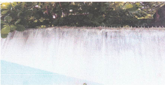
PINTRA EN MUROS ✓
