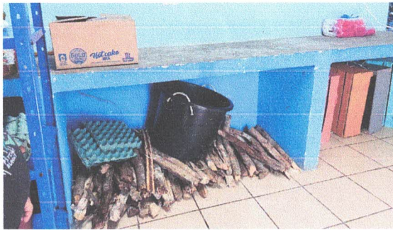
INSTALACIÓN DE PUERTAS DE GABINETE EN MESA DE CONCRETO ✓
