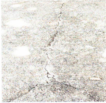
Sustitución de piso de torta de concreto
