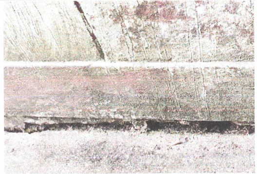
Sustitución de muro perimetral de block
