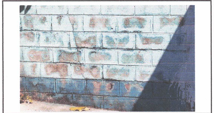
Pintura en muros interiores y exteriores
