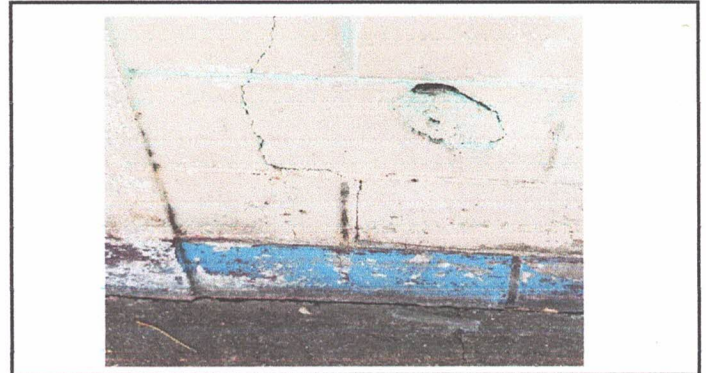
Sustitución de muro perimetral de block
