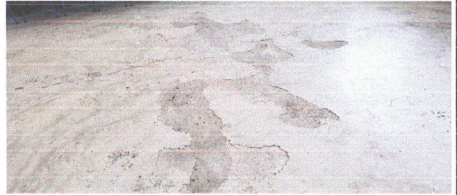
Foto 2: Sustitución de piso rústico por cerámico
