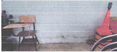
Foto 9: Sustitución de pintura de interior de aula.
