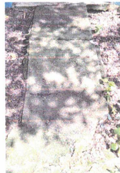
Foto 8: Sustrucción de encaminamiento. ✓
