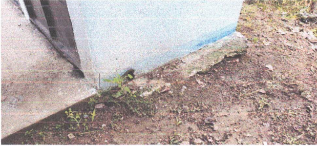
Foto7: Sustitución de banqueta alrededor de los baños
