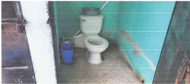
Foto 11: Sustitución de pintura de baños.
