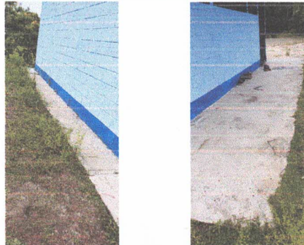
Foto 4: Sustitución de encaminamientos del aula
