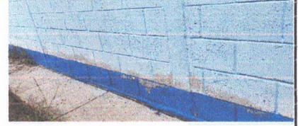
Foto 10: Sustitución de pintura de exterior de aula.
