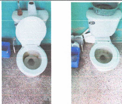
Foto 5: Sustitución de Servicios sanitarios y piso cerámico
