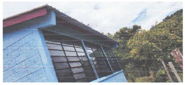
Foto 8: Instalación de canlas y bajadas de agua pluvial.
