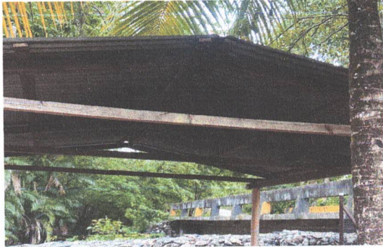
Sustitución de lámina por lámina troquelada aluzinc calibre 26
