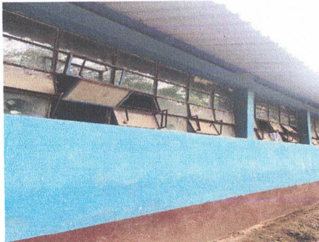
Sustitución de ventanas de metal y vidrio por ventanas corredizas de pvc
