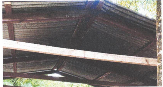
Sustitución de estructura de soporte de madera por metal
