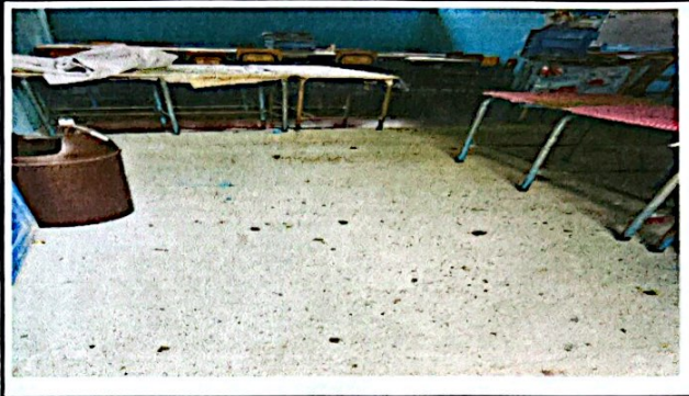
Foto: Sustitución de piso por cerámico
