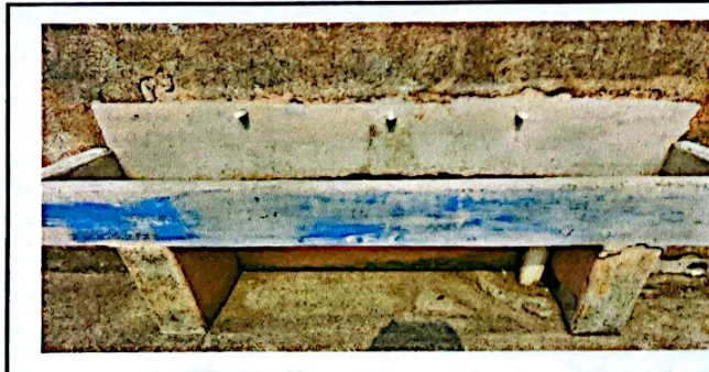
FOTO 5: SUSTITUCIÓN DE LAVAMANOS
