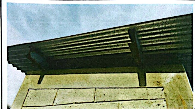
Foto 1: Sustitución de estructura de techo de metal y lámina Aluzinc calibre 26
