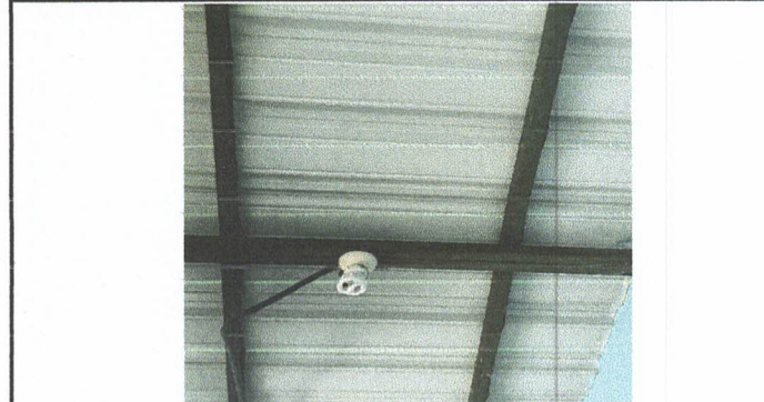
Foto 2: Sustitución de estructura de soporte de metal (Costanera) por estructura de similar consistencia
