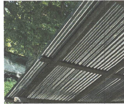
Foto 16: Sustrucción de lámina por lámina troquelada aluzinc cal 26
