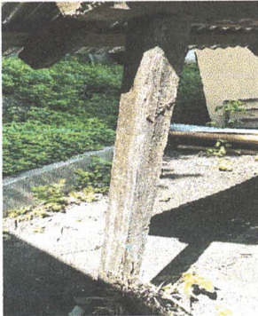
Foto 15: Sustrucción de estructura de soporte de madera por metal (costanera)
