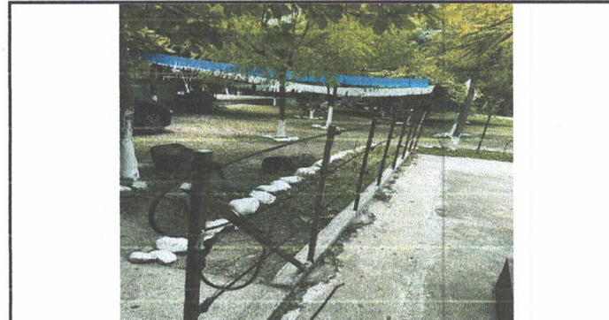
Foto 4: Sustitución de estructura de metal de circulación oxidada por barandales de metal galvanizado más pintura
