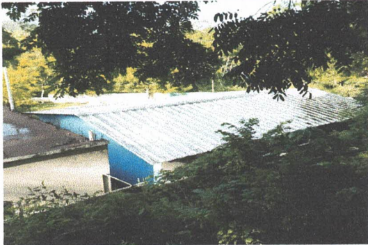
Foto 13: Sustrucción de lámina por lámina troquelada aluzinc calbre 26
