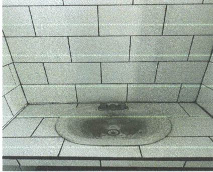
Foto 7: Sustitución de lavamanos
