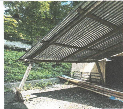
Foto 14: Sustrucción de estructura de soporte de madera por metal (costanera)
