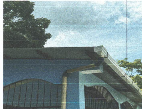
Foto 10: Sustitución de lámina por lámina troquelada aluzinc calibre 26
