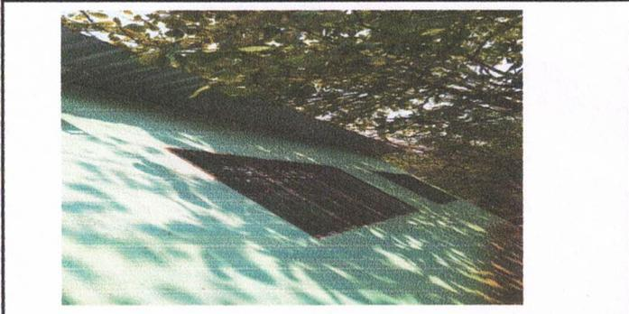
Foto 15: Reparación de estructura metálica de balcones de ventanas (lijado, sepillado, y pintura)
