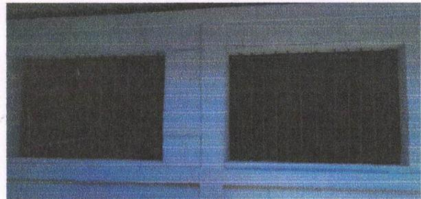
Foto 23: sustitución de las ventanas de la bodega con abarrotos por pvc. ✓
