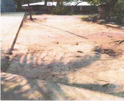
Foto 7: Sustitución de torta de concreto de cemento. ✓
