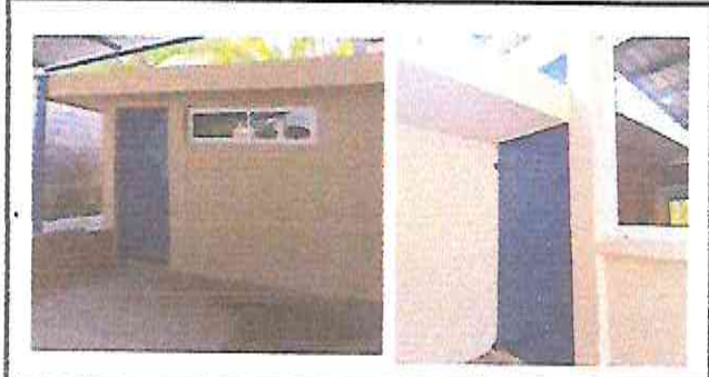
Foto 1: Impermeabilización de losa
