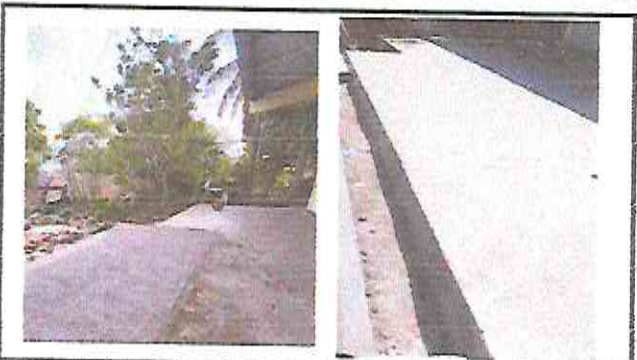
Foto 3: Sustitución o instalación de piso de torta de concreto
