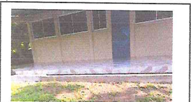
Foto 5: Instalación de grada para ingreso a corredor
