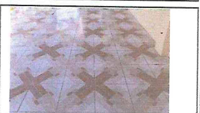
Foto 4: Sustitución o instalación de piso cerámico
