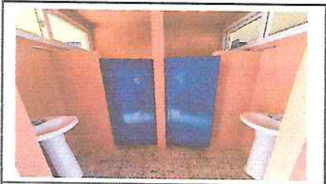
Foto 3: Sustitución o instalación de lavamanos
