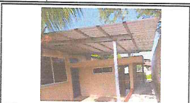
Foto 2: Sustitución o instalación de estructura de soporte de metal
