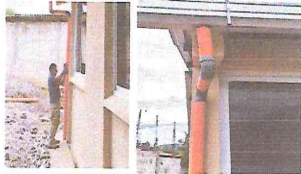
Foto 4: Sustitución o instalación de bajada de agua pluvial de tubo PVC 3"
