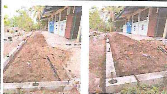
Foto 6: Cajuela de block para piso de concreto
