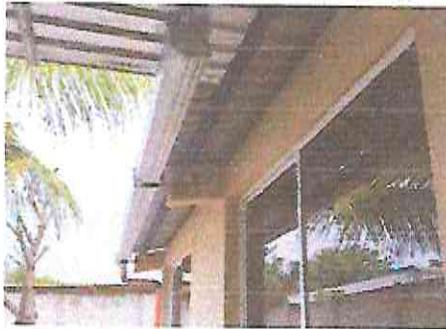
Foto 3: Sustitución o instalación de canal de metal
