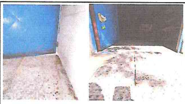
Foto 4: Sustitución o instalación de piso cerámico
