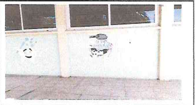
Foto 2: Pintura en muros exteriores e interiores
