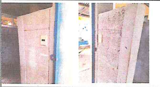
Foto 5: Sustición interruptores simples
