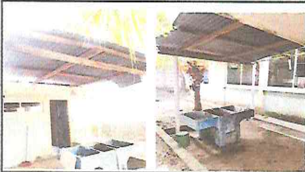
Foto 1: Sustitución o instalación de lámina troquelada aluzin
