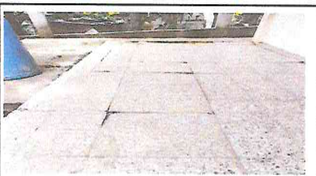
Foto 6: Reparación de piso de torta de concreto
