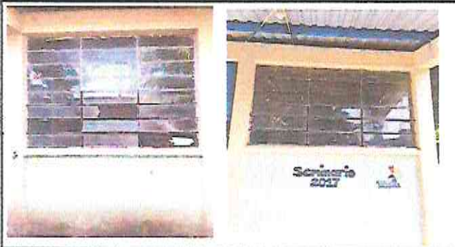
Foto 1: Instalación de ventana PVC corrediza
