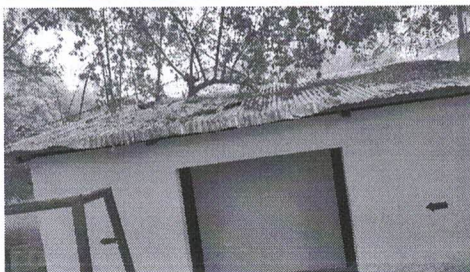
Foto 5: Sustitución de lamina en área de cocina.
