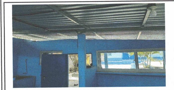
Foto 3: INSTALACION DE BALCONES CON SEDAZO EN COSINA.
