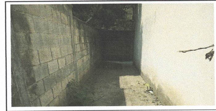
Foto 6: PLANCHAS DE CONCRETO EN PATIO.
