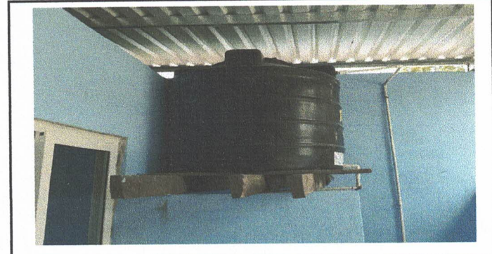
Foto 4: SUSTITUCION DE BASE DE MADERA POR METAL Y SISTERNA PARA AGUA.
