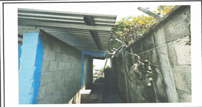
Foto1: INSTALACION DE CANAL Y BAJADAS DE AGUA.
