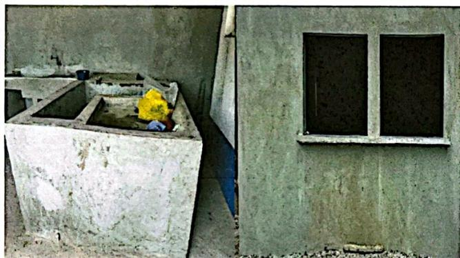
Foto 3: Cocina que necesita instalación de ceramica en, pila, pasamanos y lavatrastes
