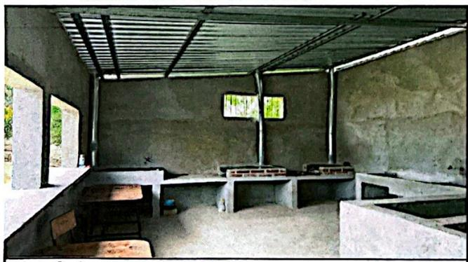
Foto 5: Cocina que necesita instalación de servicio de energía electrica, como instalación de cableado, cajas redondas para plafonera, plafonera, tapaderas, tomacorrientes, apagadores y bombillas
