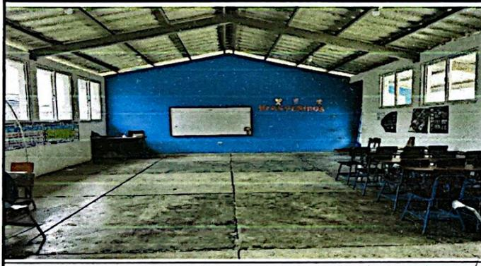
Foto 9: Módulos de aulas que necesitan cambio de piso de cemento por cerámica
