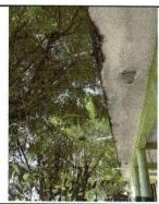
Foto 6: Módulo B, techo en mal estado por humedad
