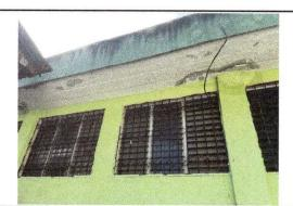
Foto 5: Módulo B, humedad en techo
