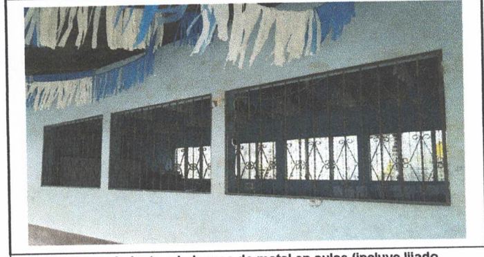
Foto 33: Mantenimiento a balcones de metal en aulas (incluye lijado, cepillado, y pintura)
