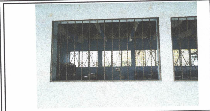
Foto 32: Mantenimiento a balcones de metal en aulas (incluye lijado, cepillado, y pintura)
