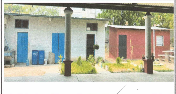
Foto 10: pintura en baños y cocina
