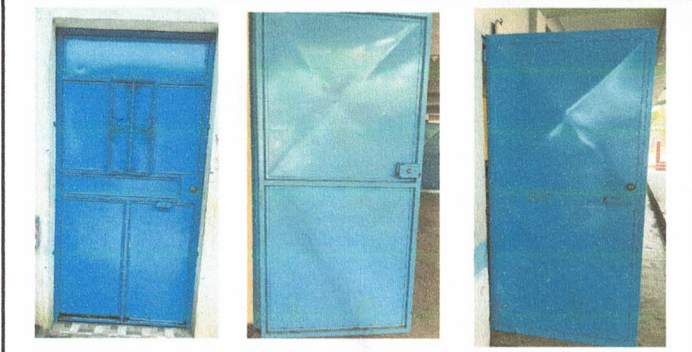
Foto 5: mantenimiento a puertas de metal
