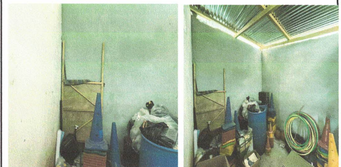
Foto 2: elaboración de estantes de concreto, instalación de cableado eléctrico, lámparas y plafoneras.
