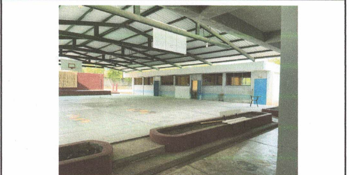
Foto 6: sustitución de lámparas LED
