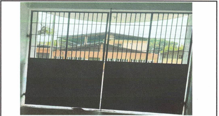
Foto 4: mantenimiento a portón (levantado porque cuesta que cierre)
