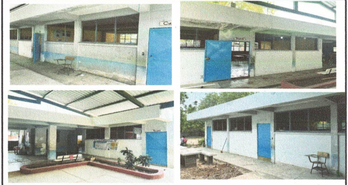
Foto 8: pintura a exterior de aulas y repello de muras y techo
