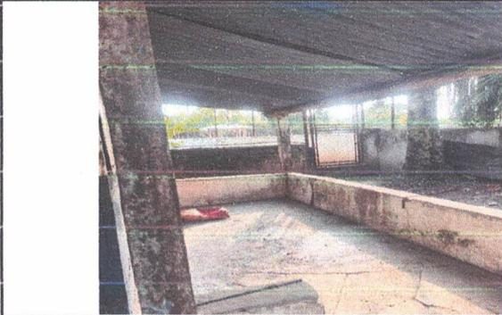
Foto1: Sustitución de lámina por lámina troquelada calibre 26 y estructura de soporte de madera por metal
