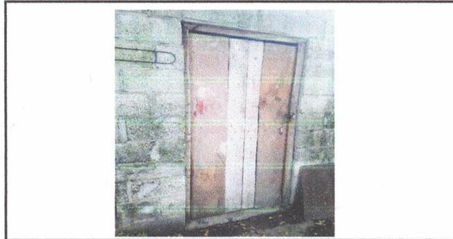
Foto 4: Sustitución de puerta de madera por puerta de metal de 1.20 mts de ancho por 2.15 mts de alto
