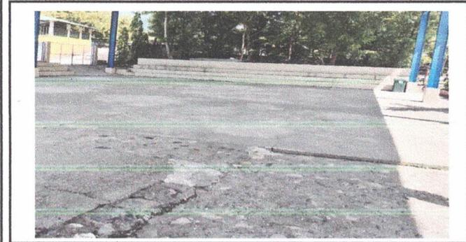
Foto 4: Sustitución de piso de torta de concreto por piso liquido
