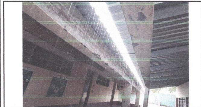
Foto 3: Sustitución de canales de concreto
