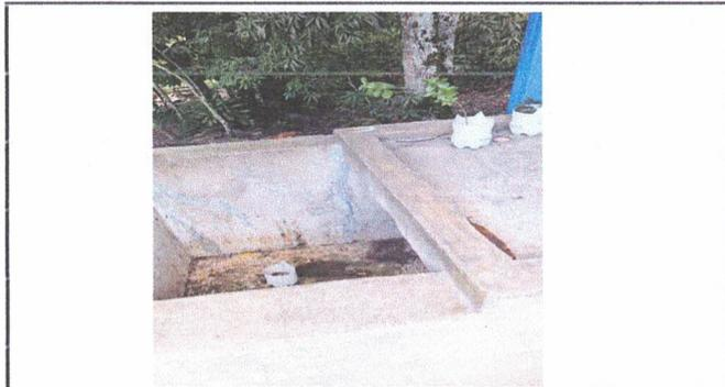
Foto 9: Reparación de pila de concreto de piso líquido por pila de piso de azulejo (Reparación de estructura, picado, cambio de valvula y colocación de azulejo)
