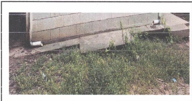
Foto 5: Sustitución de banqueta por daños en la base
