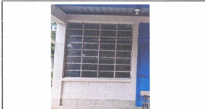
Foto 10: Sustrucción de estructura metálica y vidrios dañados por ventanas corredizas de tubo pvc
