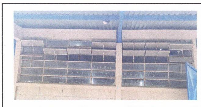
Foto 11: Sustrucción de estructura metálica y vidrios dañados por ventanas corredizas de tubo pvc
