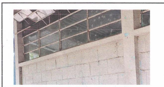
Foto 12: Sustrucción de estructura metálica y vidrios dañados por ventanas corredizas de tubo pvc
