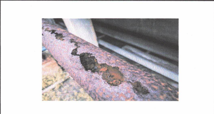
FOTO 4: SUSTITUCIÓN DE CHIMENEA DE METAL
