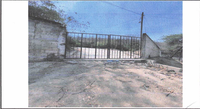
FOTO 2: SUSTITUCIÓN DE PORTÓN
