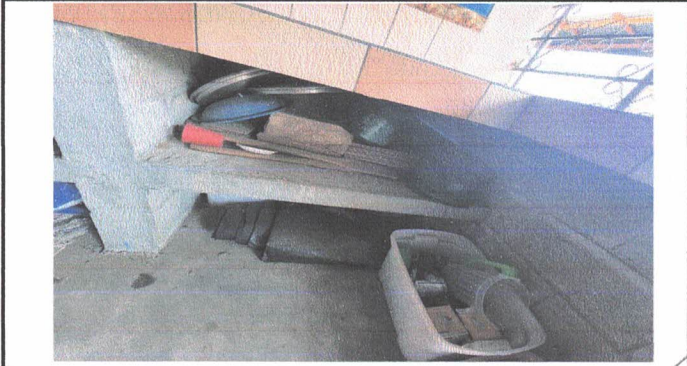
Foto 1: REPARACION DE AZULEJO EN MUEBLES DE COCINA
